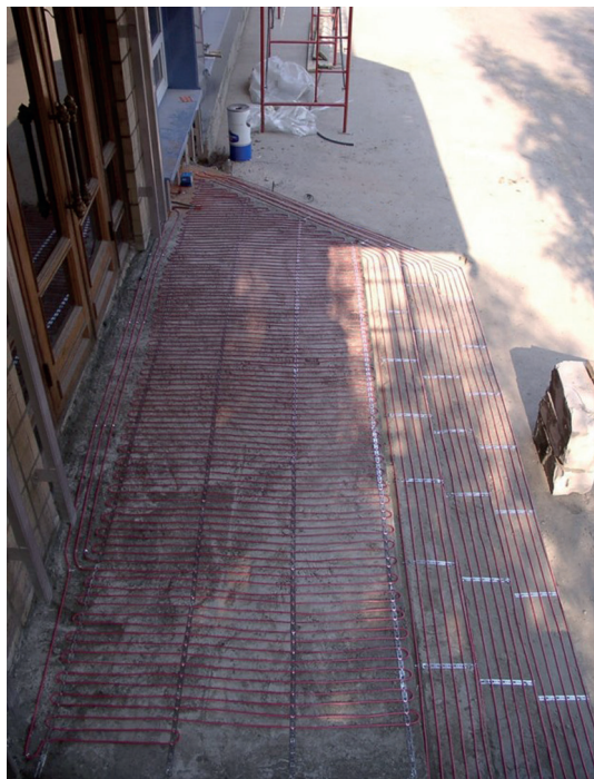
Фото 3. Монтаж системы снеготаяния на крыльце.
