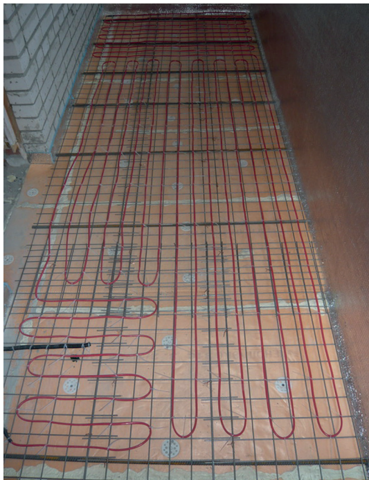
Фото 1. Монтаж теплого пола на утепленном балконе.
